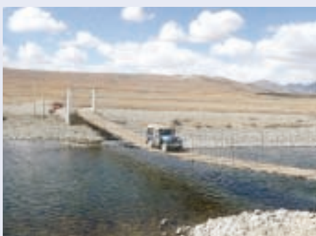
バラバニ(大きい川)の吊橋
