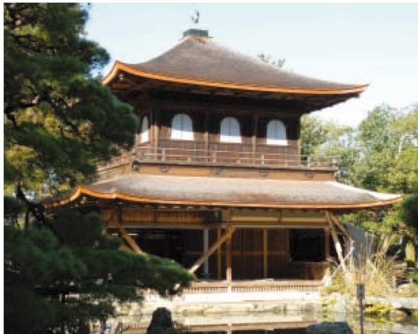
観音殿平成21年11月現在の修復状況
