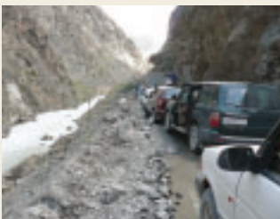
土砂崩れで立ち往生
