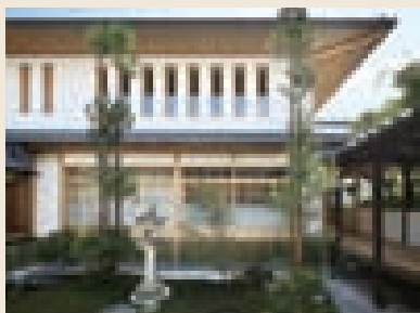
⑧ 寺務棟増築完成
