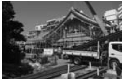
素屋根解体 平成26年8月
