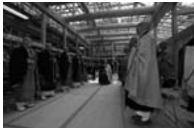
上棟式 平成25年11月
