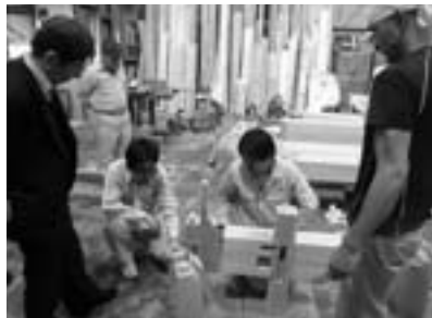
足固め仕口の確認2
