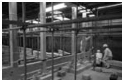
建て方 柱建込 平成25年8月
