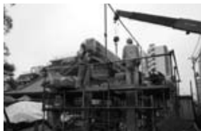
山門建て方 平成27年1月
