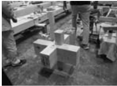
足固め仕口の確認1
