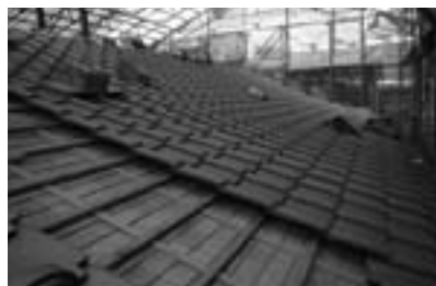
屋根工事 瓦葺き 平成26年4月
