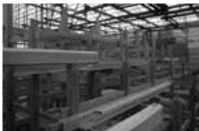
小屋組 小屋束取付
