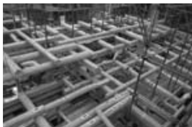
建て方 小屋丸太組 平成25年9月
