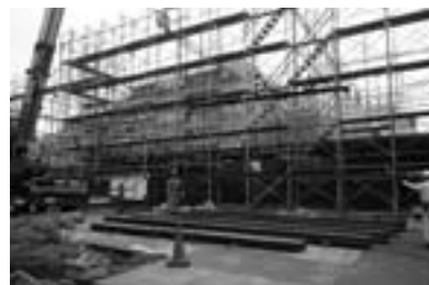
素屋根工事 平成25年7月
