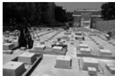
礎石工事 平成25年5月
