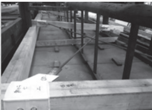
小屋裏補強（写真撮影◎株式会社 北村誠工務店）
