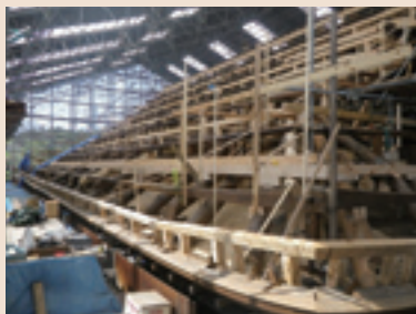
④ 母屋取り付け中
