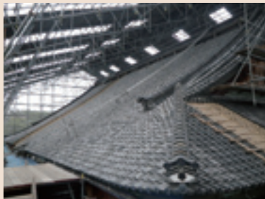
① 工事開始時現況調査
