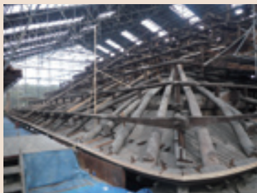
② 瓦と下地を撤去し小屋組みが見えた状態
