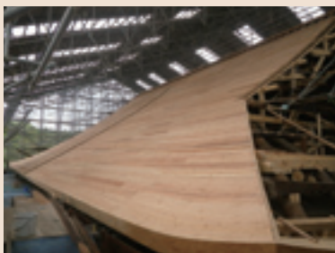
⑥ 野地板(杉材)取り付け中
