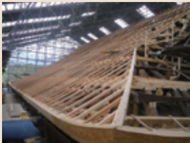
⑤ 軒付けおよび野垂木取り付け中
