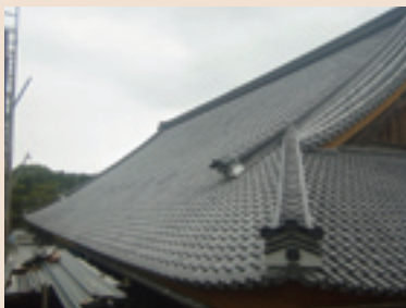
⑧ 瓦葺きをして屋根部完成
