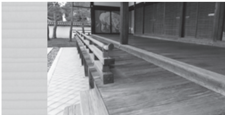
今回の修復では現状の広縁、落縁の他に濡縁の痕跡が確認された
